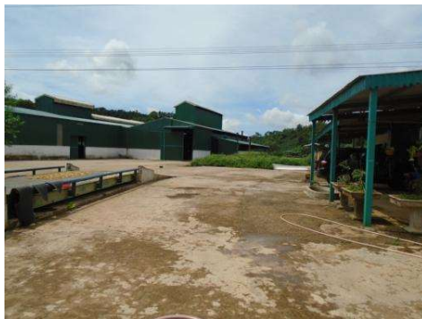
Toàn cảnh nhà xưởng
